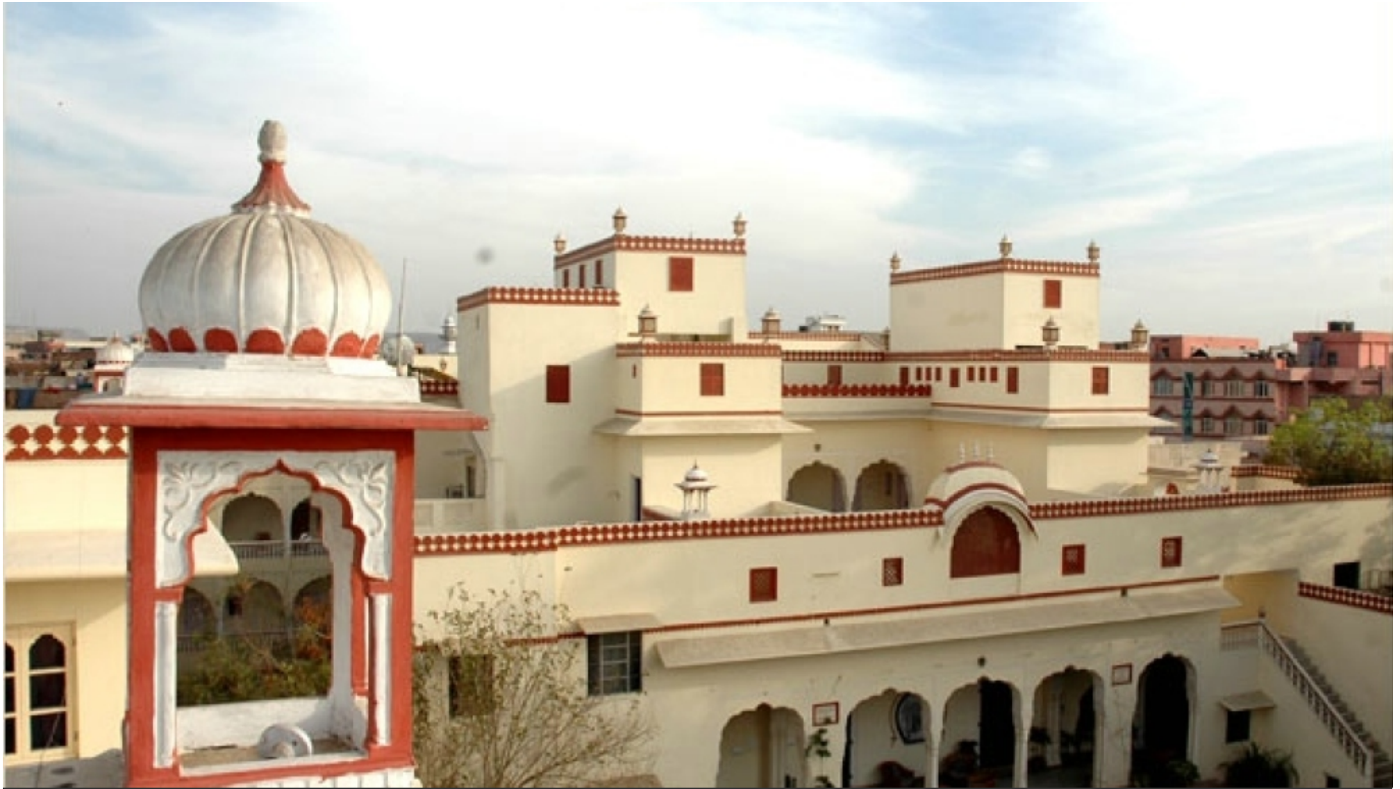
Jaipur Madawa Haveli Hauptgebäude
